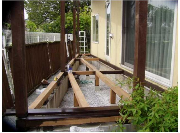
土台、大引きの上部+側面も防腐剤塗布。土台と基礎の間にはパッキンを入れ、アングルで固定し、大引きはコンクリートの固定束をアングルで固定しています。
