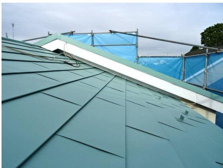
外壁+破風+軒天+雨樋+霧除け+下野屋根・全ての塗装完了しました。
