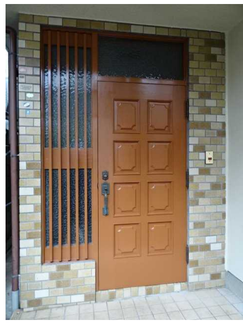
中塗り→上塗りの2回塗装で完成。
