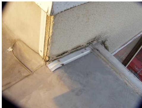
屋根接続部の漏水箇所 ↓
