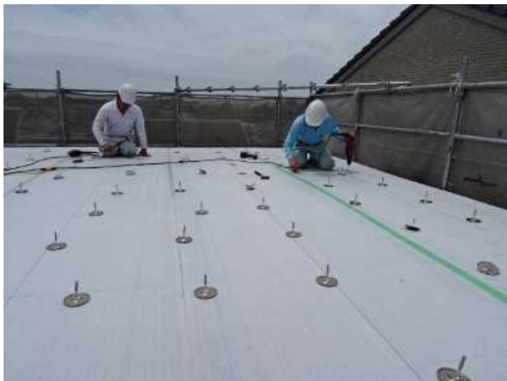
11) IHディスクを絶縁シートの上から固定しています。
