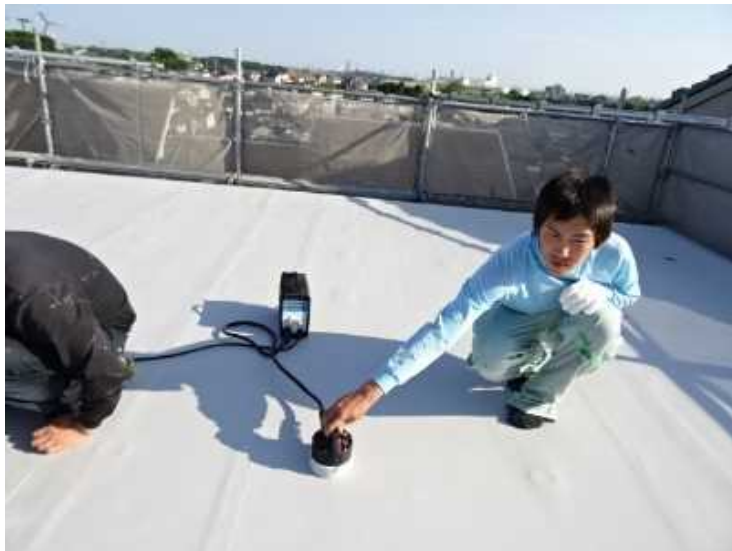
15) IHディスク+塩ビシート誘導加熱溶着
