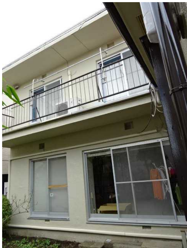
中塗り→上塗りの2回塗装で完成。
