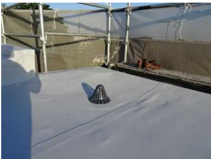
12) 防水シートの端末まで正確に固定できています。
