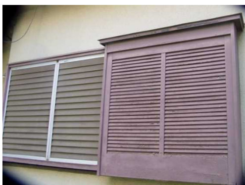
戸袋& 窓枠の塗装・下塗り&上塗りで完成
