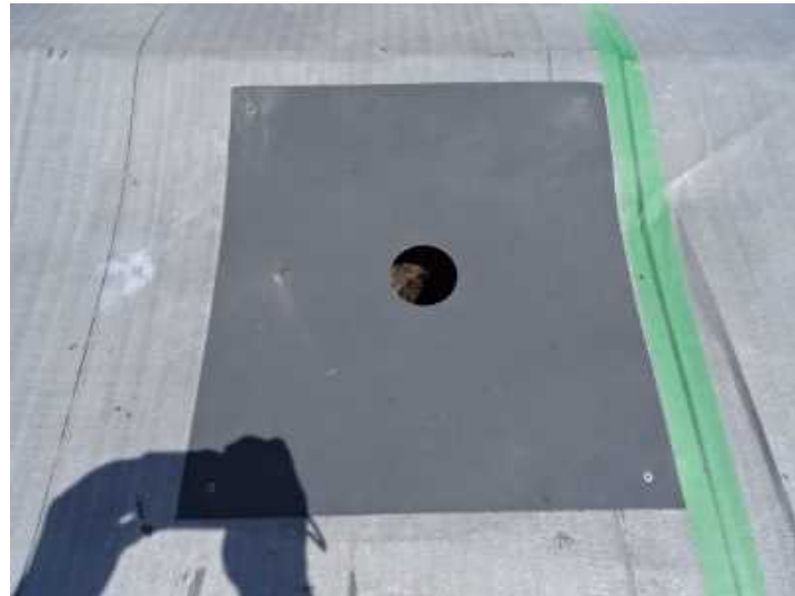
10) 塩ビドレンタテ型・ストレーナー設置完了
