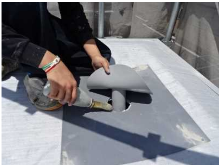
11) IHディスクを絶縁シートの上から固定しています。
