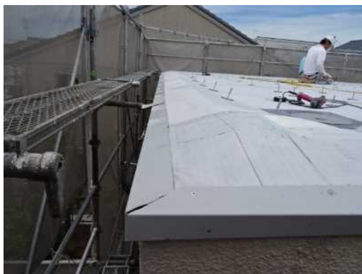
12) 防水シートの端末まで正確に固定できています。
