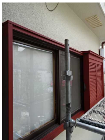
戸袋& 窓枠の塗装・下塗り&上塗りで完成
