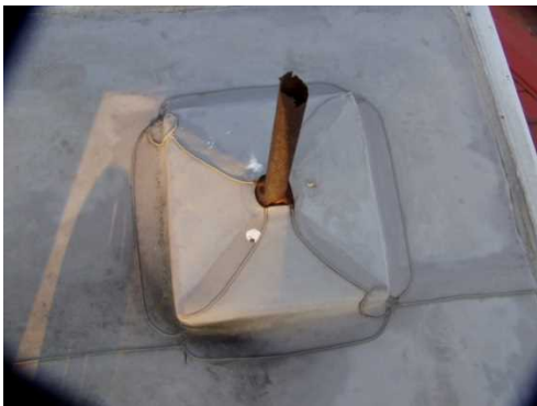
アンテナ撤去後の漏水箇所 ↓
