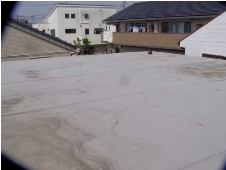
アンテナ撤去後の漏水箇所 ↓
