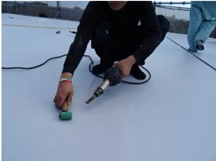
15) IHディスク+塩ビシート誘導加熱溶着
