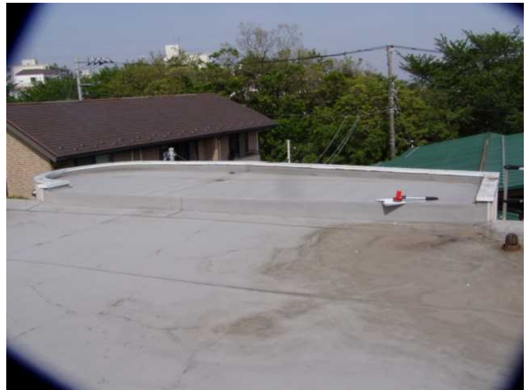
屋根接続部の漏水箇所 ↓
