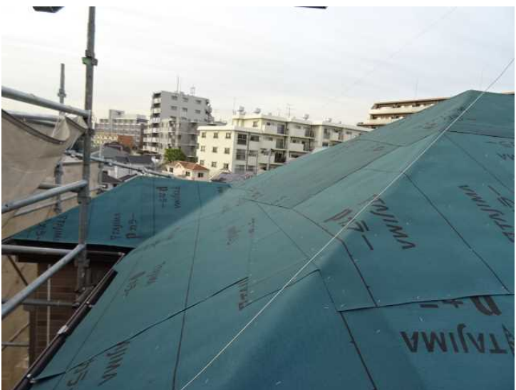
⑤ アスファルトルーフィング(防水シート)の敷き込み(南面)
