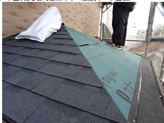
⑨ 下屋、葺き替え仕上げ中 (玄関ポーチ屋根)
