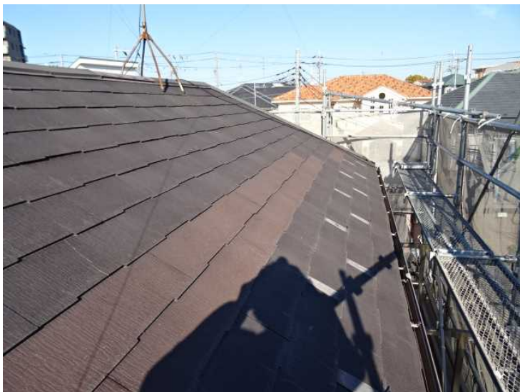
① 葺き替え前の屋根
