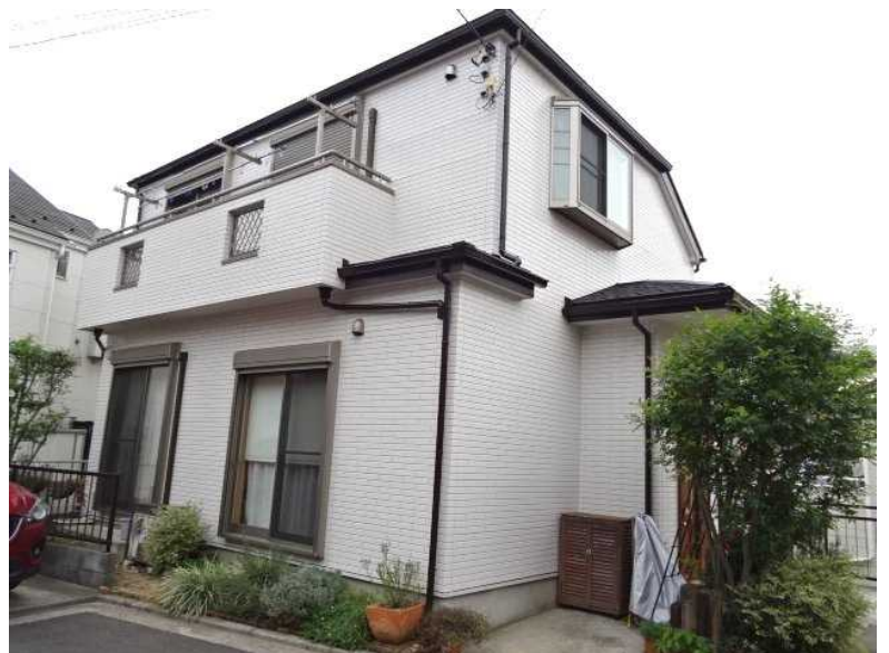
④ サイディング塗装完成(東側)
