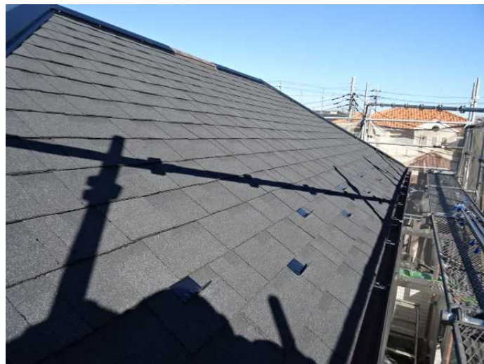
⑩ 下屋、葺き替え仕上げ完成(4カ所の下屋工事完成)
