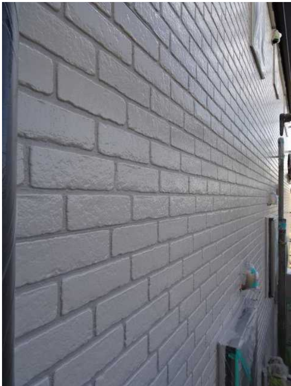
⑤ 貼り替えサイディング・タイル調仕上げ塗装済み。
