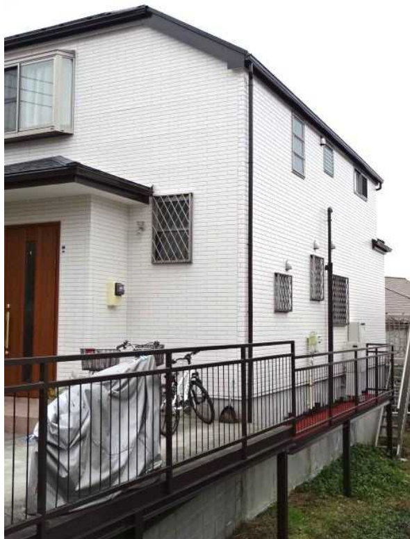
③ サイディング貼り替え(西面)とそう完成
