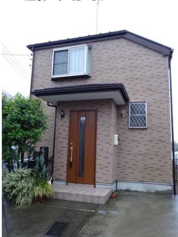
(塗装工事 施工前)
