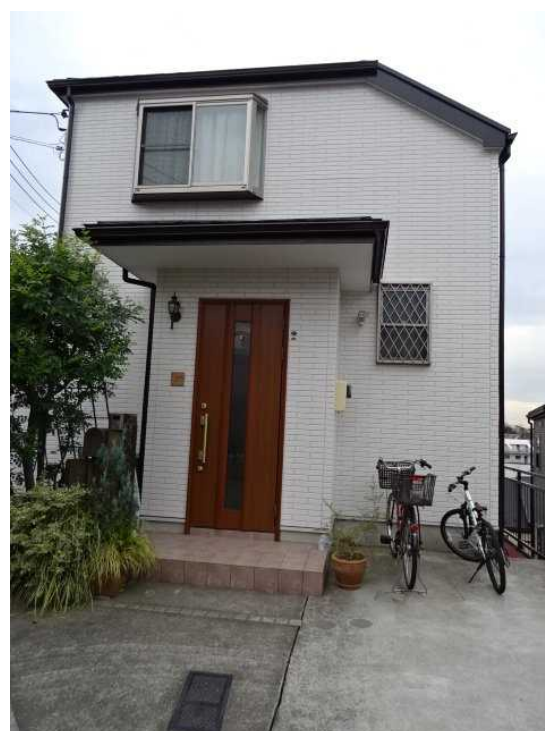
(塗装工事 施工後)
