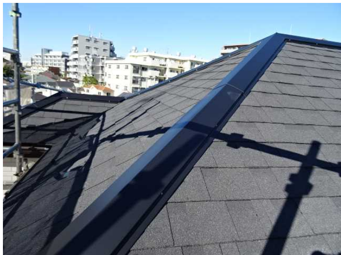
⑨ 下屋、葺き替え仕上げ中 (玄関ポーチ屋根)
