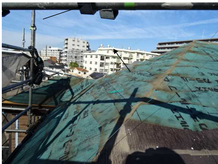
⑤ アスファルトルーフィング(防水シート)の敷き込み(南面)
