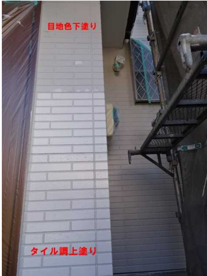
① 目地色塗料下塗り工事
