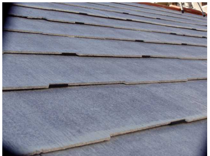
⑥ タスペーサー挿入完了(全面で 約 500 個挿入)
