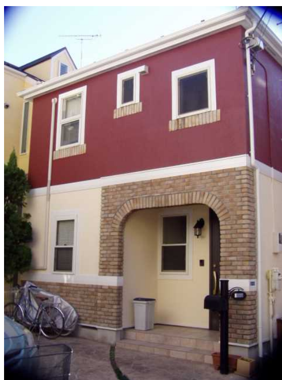
(塗装工事 施工後)
