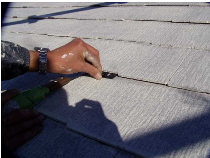
⑤ タスペーサー挿入(屋根の縁切り)
