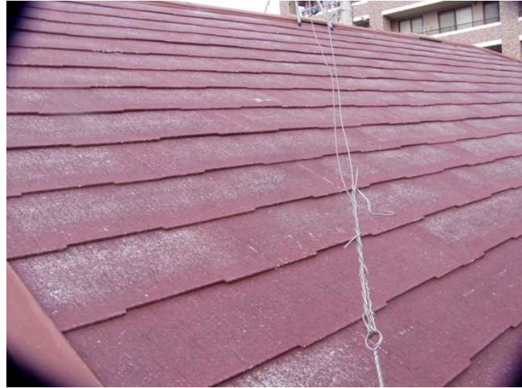
② 高圧洗浄後の屋根
