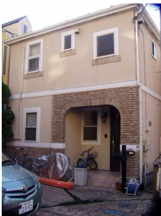
(塗装工事 施工前)
