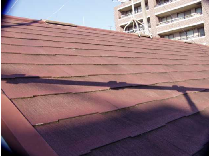
① 高圧洗浄前の屋根
