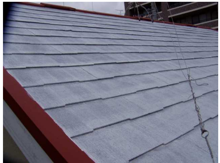
④ 下塗り塗料・サーモアイシーラー塗装
