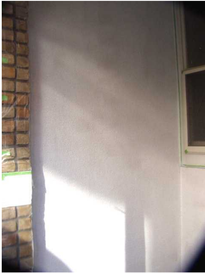
玄関ポーチ内壁下塗り・(パーフェクトサーフ)(白)
