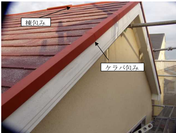
③ 棟包み&ケラバ包みの錆止め塗装
