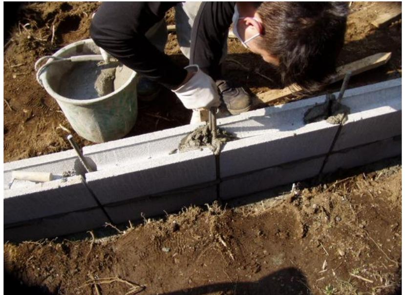
⑤ 目地と天端のモルタル仕上げ & フェンス柱設置
